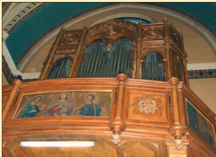
Immagini della lavorazione di restauro dell'organo descritta più avanti
