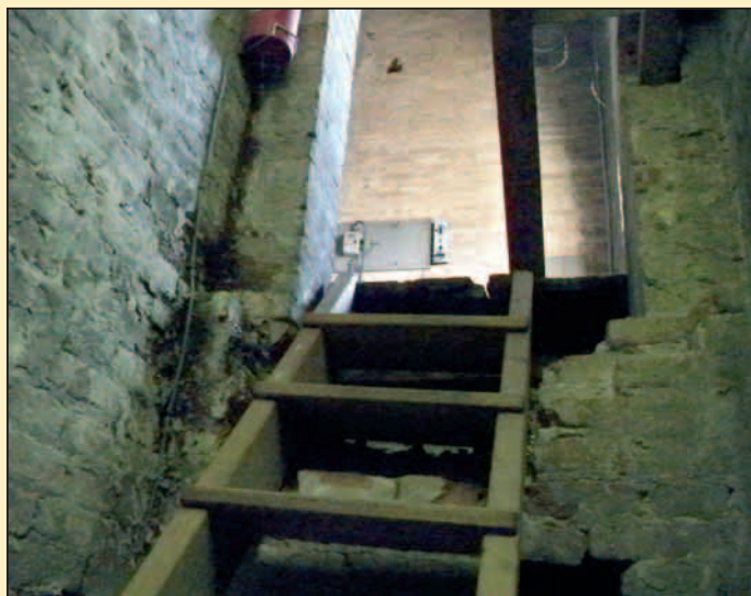
Le strutture i solai e camminamenti tra muri interni ed esterni
