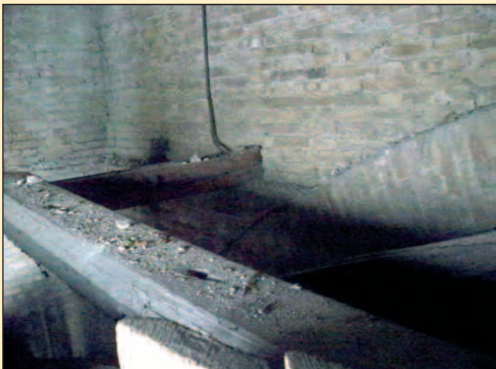
I camminamenti precari, da rendere agibili e a norma, che corrono tra il muro interno ed esterno
