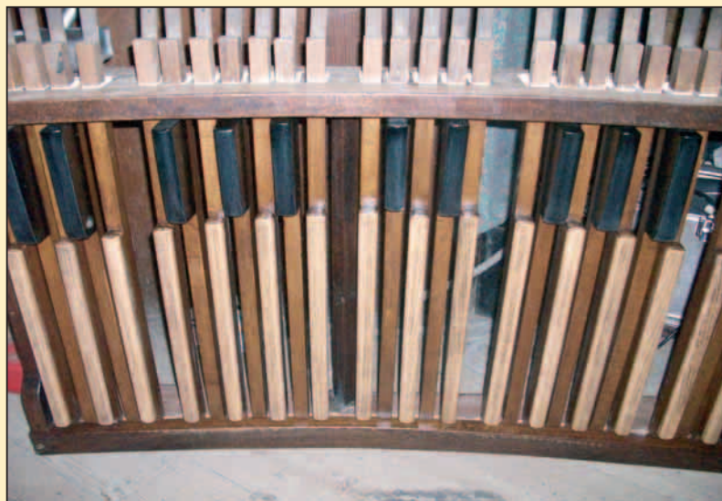
Immagini della lavorazione di restauro dell'organo descritta più avanti
