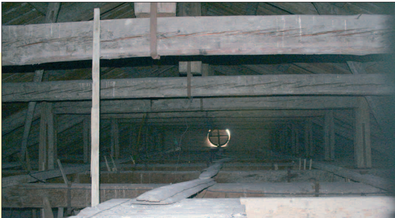
Il sottotetto della nostra Chiesa completamente da restaurare e rendere agibile, si possono notare i paletti che sorreggono la volta
