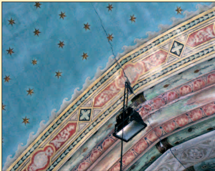
Particolari della volta con evidenti le fessurazioni e i danni da riparare
