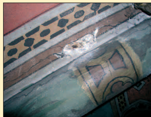
Le attuali crepe sull'intonaco della volta
